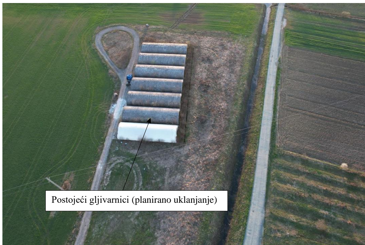
Slika 11. Prikaz postojećeg stanja na lokaciji (Izvor: Solvis, kolovoz 2023.)
