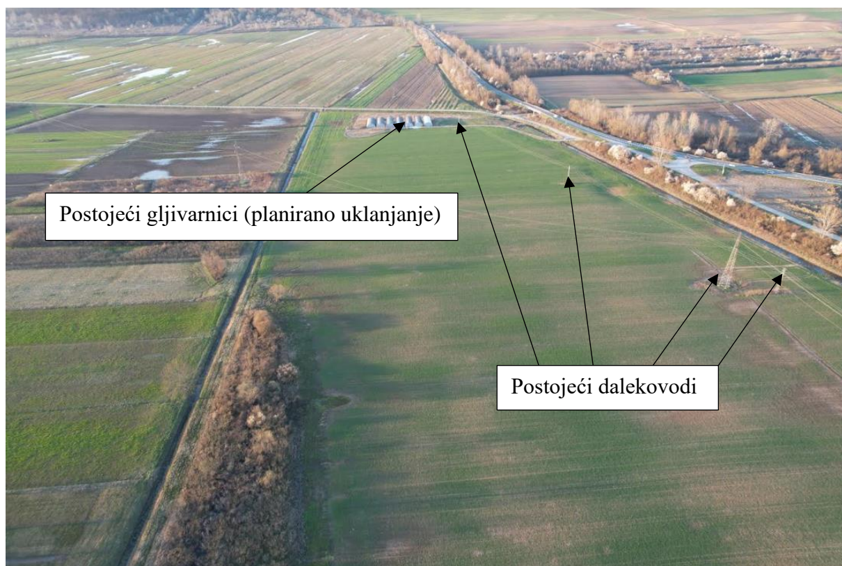
Slika 10. Prikaz postojećeg stanja na lokaciji (Izvor: Solvis, kolovoz 2023.)
